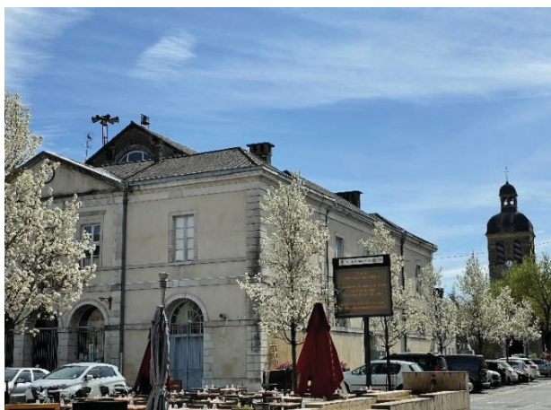
Photographie 14 : Mairie de Navarrenx
