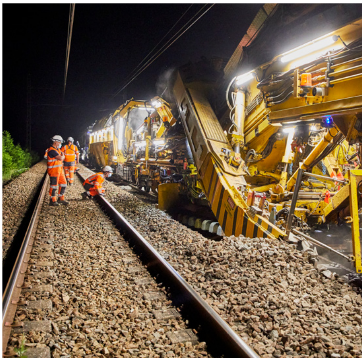
Travaux de modernisation de la voie réalisés au moyen d'une «suite rapide» entre Talence et Biganos.
