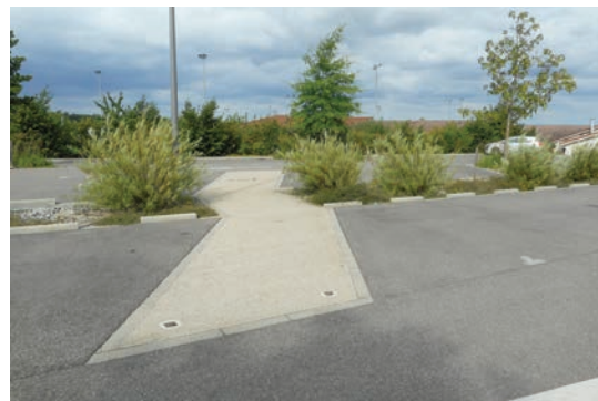
Le cheminement de ce parc est conforme aux recommandations d'accessibilité et le revêtement est contrasté pour les personnes aveugles et malvoyantes (PAM).
