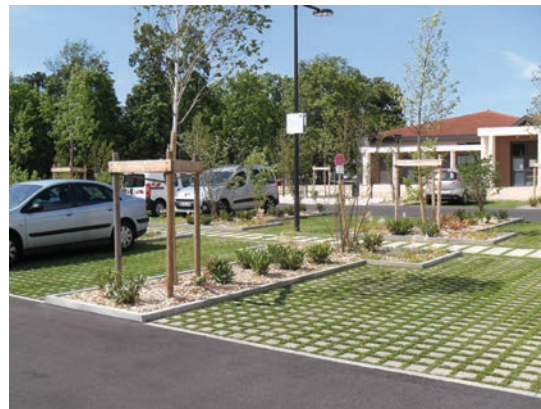
Les emplacements sont réalisés en pavés de béton avec des joints engazonnés. Ils s'inscrivent bien dans le cadre du parc et des équipements publics qu'ils desservent.
