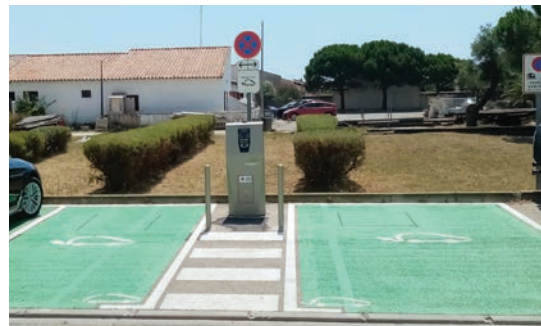
Exemple d'un emplacement accessible aux PMR. La borne répond aux critères, notamment à la hauteur des commandes entre 0,80 m et 1,30 m. La peinture de l'emplacement n'est pas souhaitée.
