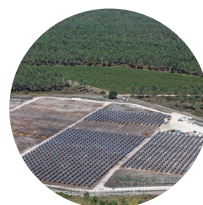
Centrale solaire au sol - Losse
