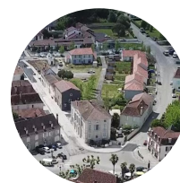
Ancien site industriel - Sauveterre / Béarn
