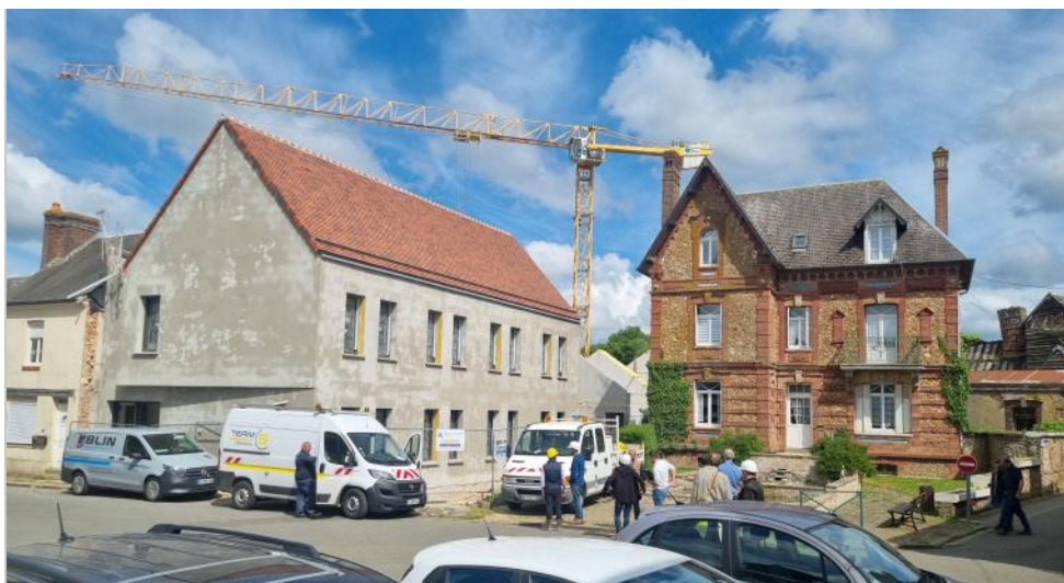
État projeté de l'ilot de l'ancienne poste et avancement du chantier mai 2025. Crédit : Bettinger Desplanques Architectes
