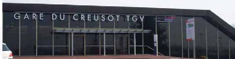
L'entrée de la gare du Creusot
