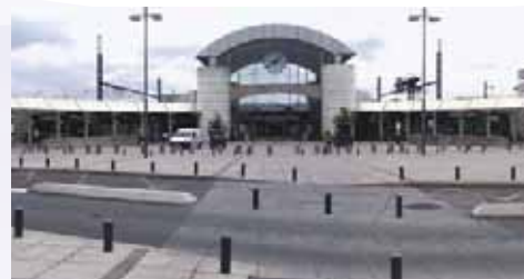
L'entrée principale Nord
