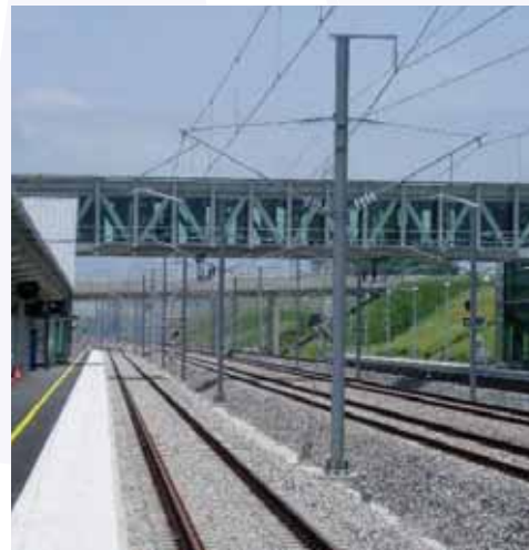
Les quais et la passerelle
