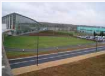
La gare TGV et ses stationnements
