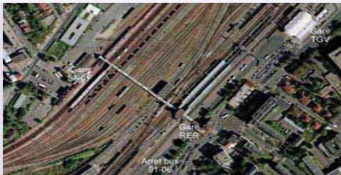
Le pôle multimodal de Massy-Palaiseau
