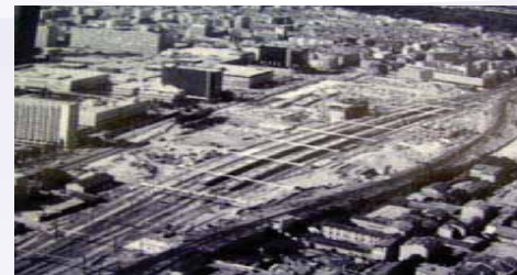
La gare en travaux
