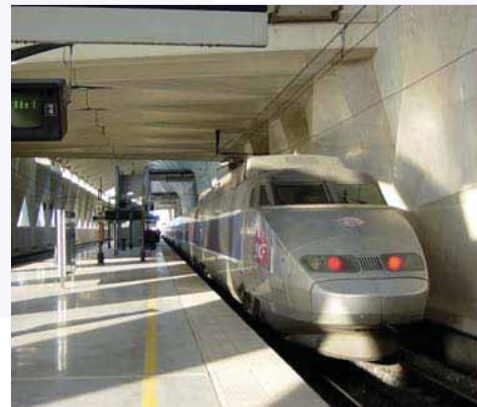
Les quais semi-enterrés
