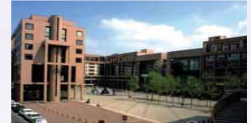
L'entrée de la gare côté Lyon
