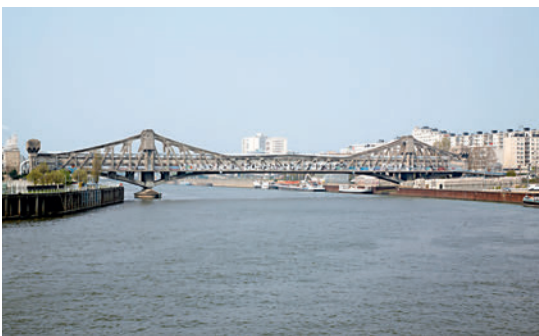
A GAUCHE Le pont aux Câbles, bien que dégradé et présentant des accès peu lisibles, assure une liaison piétonne et cyclable entre Charenton-le-Pont et Ivry-sur-Seine et offre une belle vue sur la confluence.
