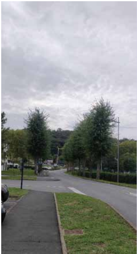
Discontinuité dans le cheminement piéton
