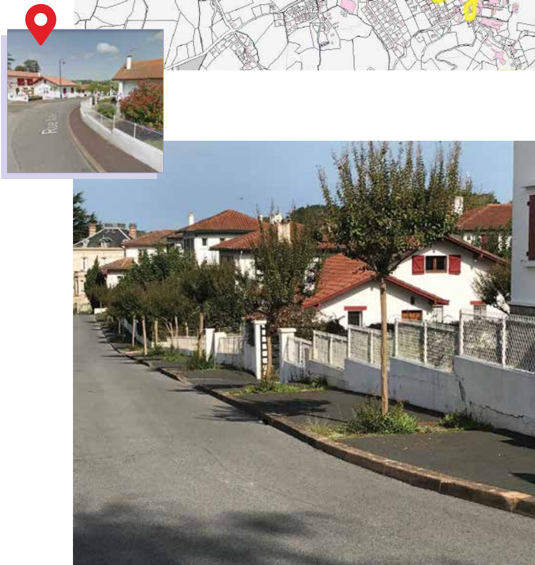
Le choix a été fait de placer l'alignement d'arbres sur le trottoir, ce qui entrave le cheminement des usagers piétons et à mobilité réduite.
