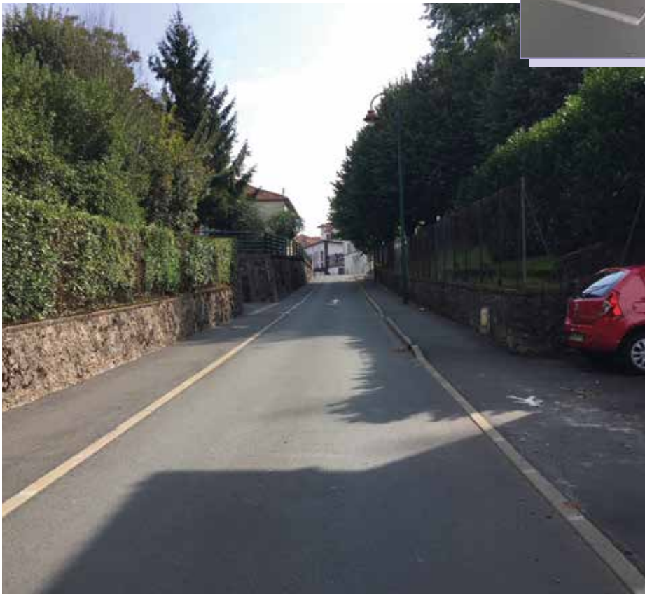
Du fait du sens unique, cette voie étroite peut bénéficier de deux trottoirs, signalés au niveau des passages-bateaux pour garantir leur respect
